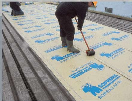
Faire chevaucher les rouleaux adjacents de 75 mm (3 po). Tous les joints transversaux seront de 150 mm (6 po). Espacer les joints transversaux d'au moins 300 mm (12 po).
