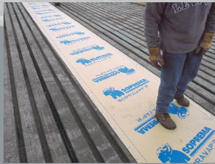
Aligner le rouleau parallèlement aux cannelures du platelage d'acier. Assurer la présence d'un support continu à tous les chevauchements de membranes.
