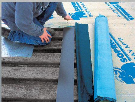
Lorsque le pare-vapeur est installé directement sur un platelage d'acier, prévoir une feuille de métal mince sous les chevauchements transversaux.
