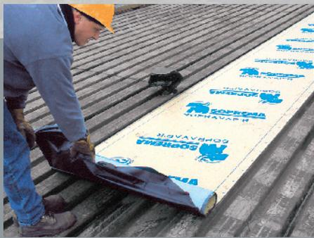
En partant du bas de la pente, dérouler sur la surface la membrane SOPRAVAP'R sans la coller pour être en mesure de l'aligner. Ne pas retirer le film siliconé détachable immédiatement.
