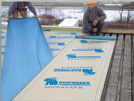
Dégager une extrémité du film plastique siliconé détachable afin de coller cette partie de la membrane à la surface. Retirer ensuite ce film de protection dans un angle de 45°, de façon à éviter les plissements de la membrane.
